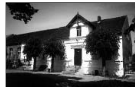
Abb. 5 Eingangsgestaltung durch Kopflinden in Fresdorf (Potsdam-Mittelmark)
