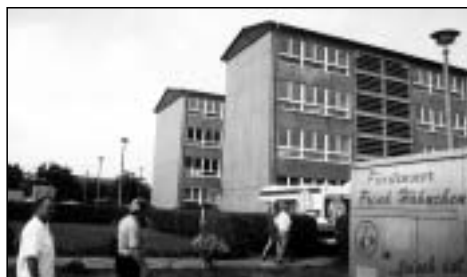
Abb. 7a Schulgebäude in Vierraden (Uckermark) ohne Einfriedung durch Bäume
