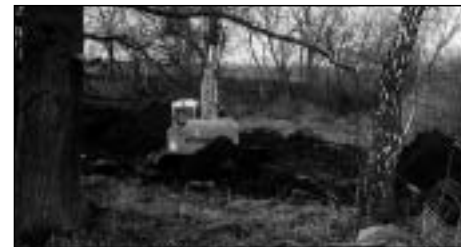
Ausbaggern eines Feldsolls
